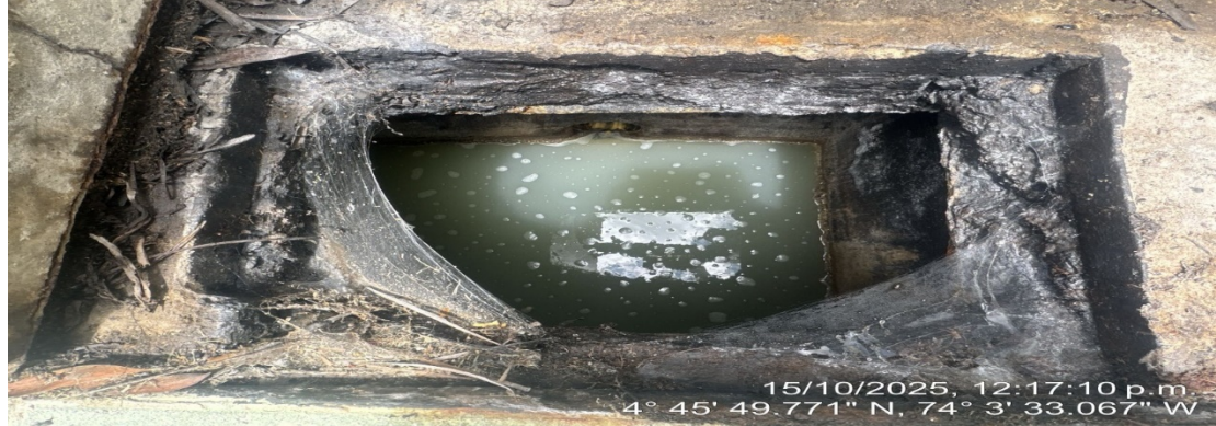
Fotografía 5. Pozo séptico 3 Portería.
